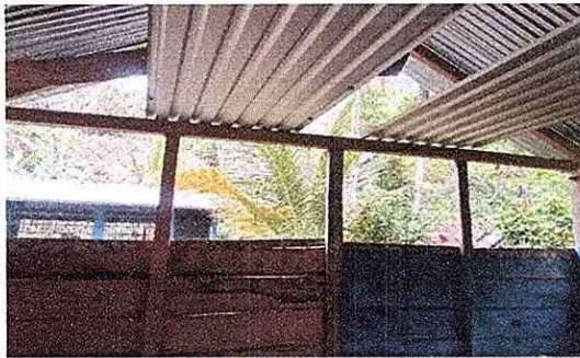
sustitución de ventanas de mallas por balcones de metal.
