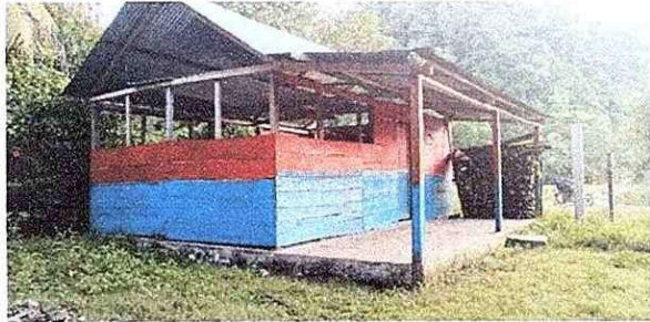
Foto1: Reparacion de techo
