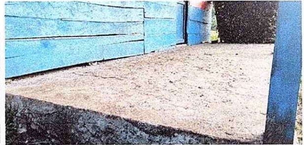
Foto 2: mejoramiento de piso rustistico por piso liso
