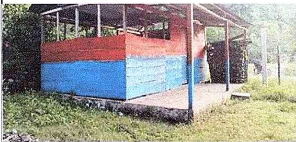
Foto 5: Sustitución de paredes de madera dañadas por la lluvia
